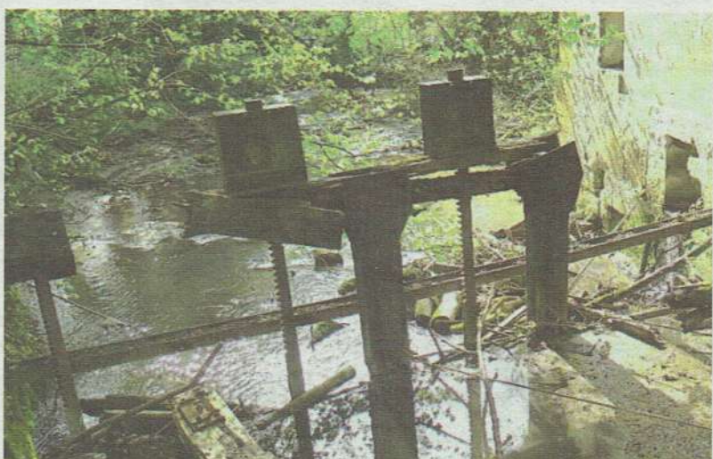
Le système de vannes et de turbines ne fonctionne plus au moulin de Sailleville. Si bien que la rivière s'est élargie.
