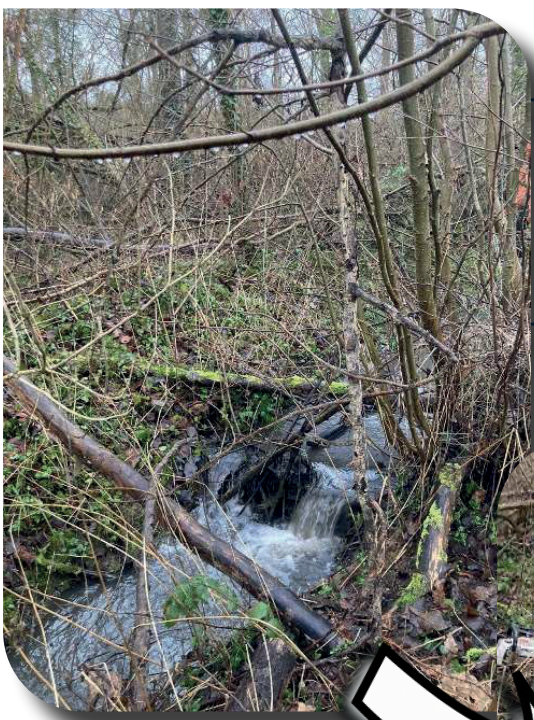
Avant les travaux d'entretien, ru du Rayon : un seuil naturel s'était formé et de nombreux débris d'arbres créaient un obstacle à l'écoulement.
