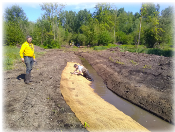
Terrassement des berges en pente douce jusqu'au raccord au terrain naturel
