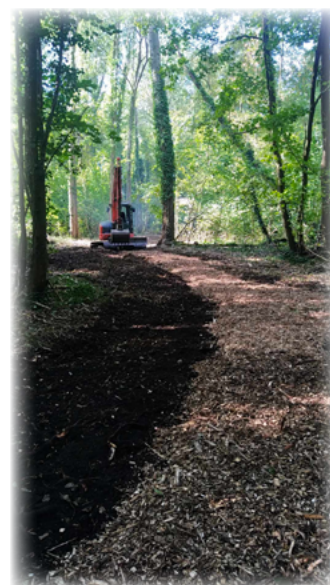
Mise en place de 15 cm de copeaux pour créer un sentier surélevé
