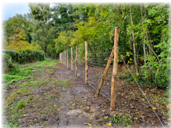
Clôture à l'entrée du site, rue Marcel Deneux
