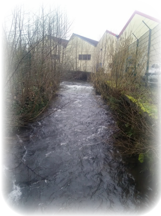
Vue du seuil de Bailly le Bel, depuis l'aval
