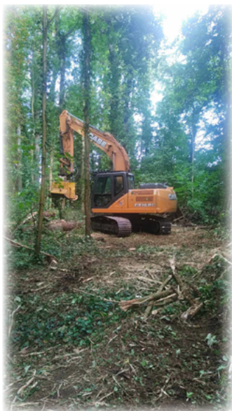
Dégagement de l'emprise du futur sentier sur 6 mètres de large
