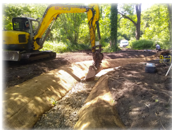
Mise en place d'un géotextile biodégradable sur les berges afin de les protéger de l'érosion
