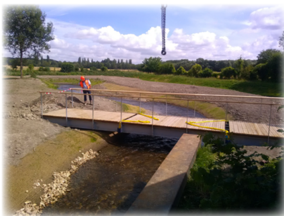
Mise en place d'une passerelle
