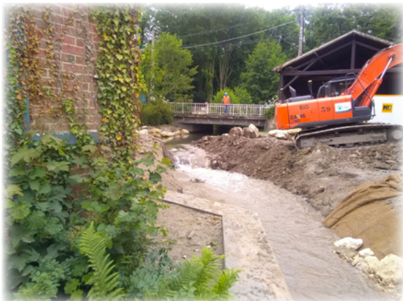
Ouverture progressive du lit à l'amont
