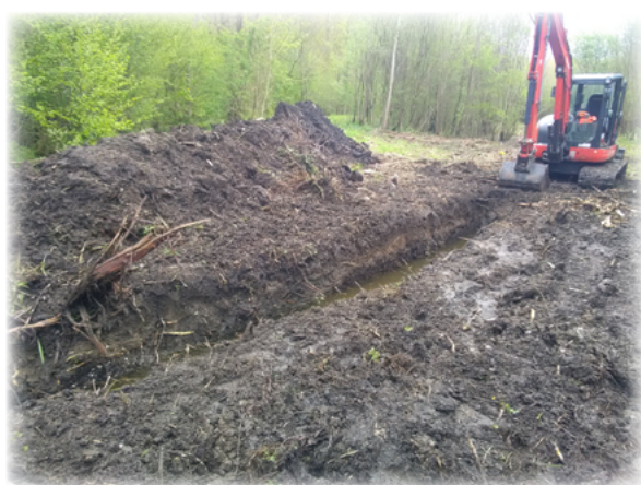
Terrassement des berges en pente douce jusqu'au raccord au terrain naturel
