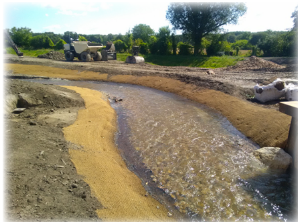
Remplissage progressif du nouveau lit
