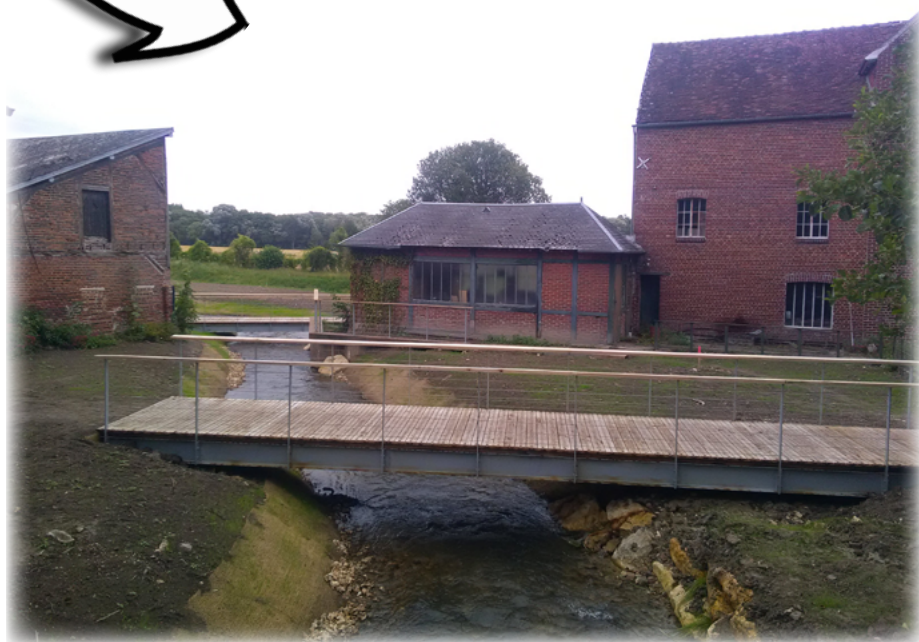
Le moulin de Ramecourt, avant et après travaux
