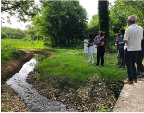
Le tracé du ru de la Gardie a été confirmé pour favoriser son écoulement.
