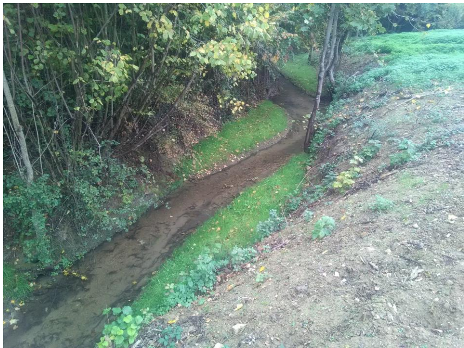
Restauration de l'Arré
