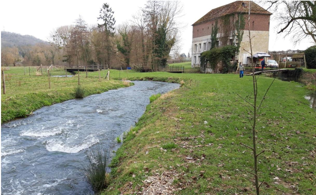
*Exemple de bras de contournement réalisé après remblaiement préalable de la rive gauche du bief dans des conditions identiques au site du moulin de la Commanderie (projet de RCE du moulin de Froisselle sur l'Aronde à Clairoux – SOGETI 2019)*
