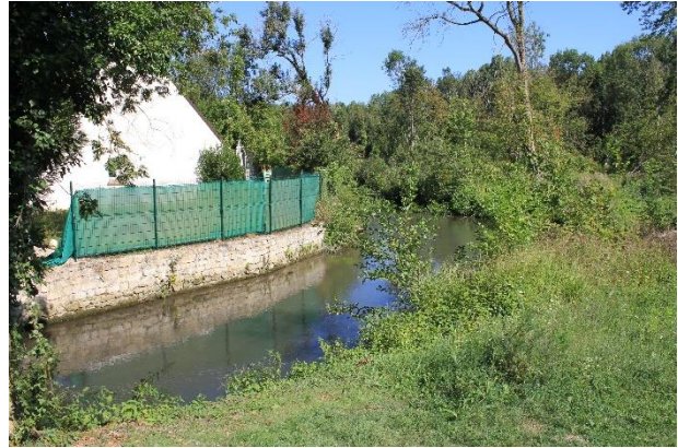
Figure 10 : Bras de décharge en amont du pont communal
