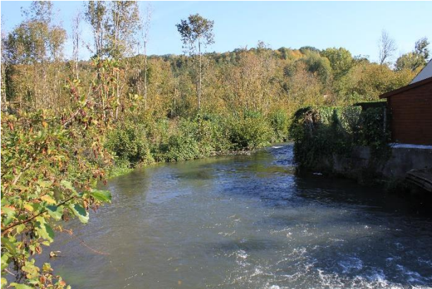
Figure 9 : Bras de décharge depuis l'aval de l'ouvrage
