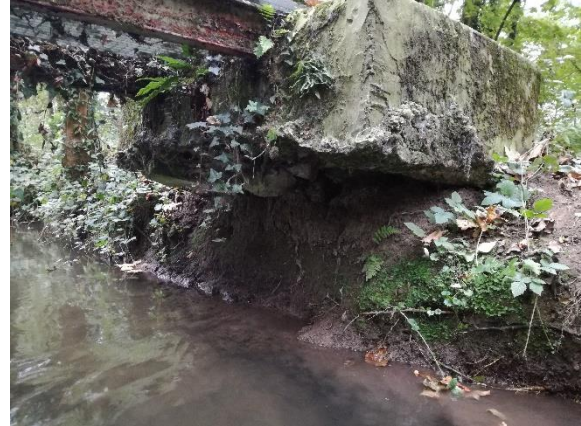
Figure 25 : Affouillement en rive gauche
