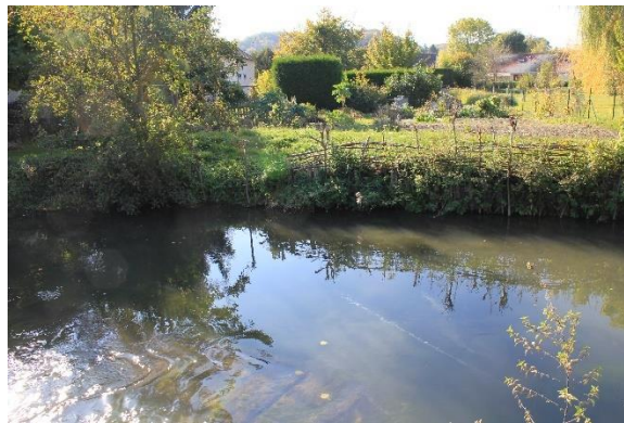
Figure 6 : Berge en rive droite maintenue par des pieux bois
