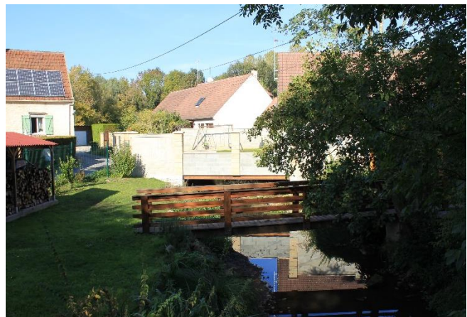
Figure 8 : Succession de passerelles privées enjambant le canal usinier
