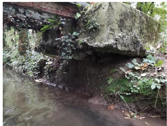
Figure 35 : Affouillement en rive gauche
