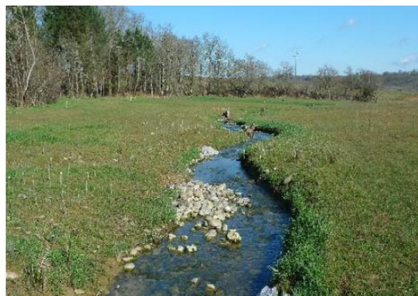
Figure 37 : Exemple de création d'un nouveau bras de cours d'eau avec mise en place de structures de diversification des écoulements (source : Biotec)
